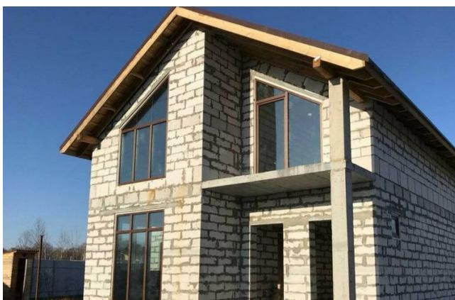
Дома из пеноблоков возводятся достаточно быстро. Это объясняется большим размером самих блоков, а также лёгкостью их обработки. Данный материал легко разрезается ножковкой. Так как пеноблоки имеют не такую высокую прочность, как кирпич, то при возведении мансарды верхнюю часть стен нужно укрепить при помощи армирования.
