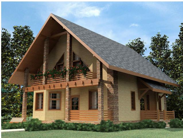
Данный вид кровельной конструкции состоит из двух скатов. Нижней частью они крепятся к наружным стенам. Вверху скаты соединяются при помощи конька. Стена, расположенная между двумя скатами, называется фронтонаом двускатной крыши. Такая несложная конструкция обладает следующими преимуществами:
