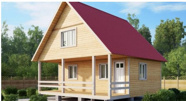
Крыша этого вида пользуется большим спросом из-за простоты монтажа, а также из-за своих превосходных эксплуатационных характеристик. Она хорошо справляется со снеговой и ветровой нагрузкой. Но это верно лишь при том условии, что при разработке проекта двускатной крыши, были правильно выполнены расчеты и соблюдены все строительные нормы.
