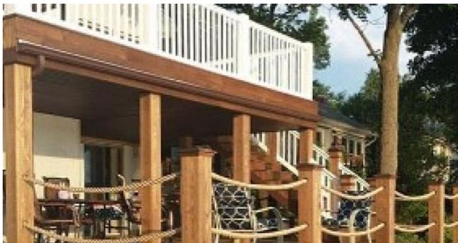
Терраса — это открытая площадка, которая **базируется на фундаменте или специальных опорах**. Для террасы используется столбчатый, ленточный, винтовой или свайный тип основания, выбор которого зависит от назначения планируемой постройки. Пристройка возможна и без фундамента. В этом случае несущие балки ложатся на опоры, в основании которых лежит тротуарная плитка или подобное по надежности покрытие.
