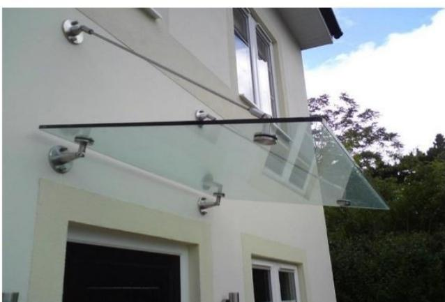
**Навесные.** Крепятся к стене здания с помощью опор.
