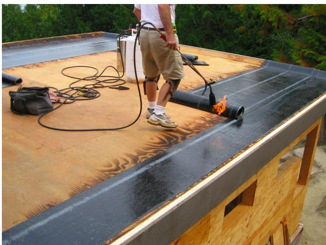
Отличаются по составу, а также по способу монтажа. Их наклеивают при помощи мастики, наплавляют, разогревая горелкой или крепят механическим способом. Также есть самоклеящиеся битумные покрытия.
