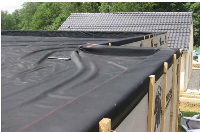
Данное покрытие имеет высокую стоимость. Основа материала — этилен пропилен диеновый каучук. Обладает хорошей эластичностью, но не так надежен, в сравнении с другими вариантами. Крепится при помощи самоклеящейся ленты.
